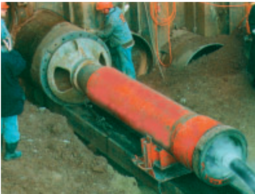
Ramme beim Vortrieb eines Stahlrohres DN 1200
