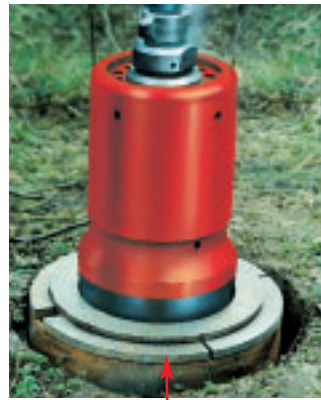
Ramme beim Vortrieb eines Stahlrohres DN 1200
